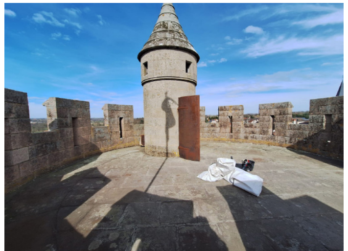
Décapage et réfection des joints d'une des tours
