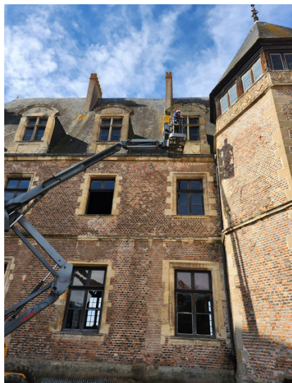
Réparation et vérification des vitrages et gouttières
