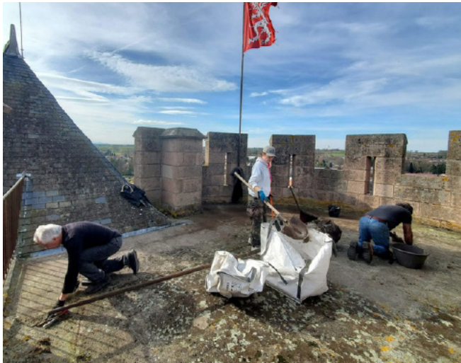
Décapage et réfection des joints d'une des tours
